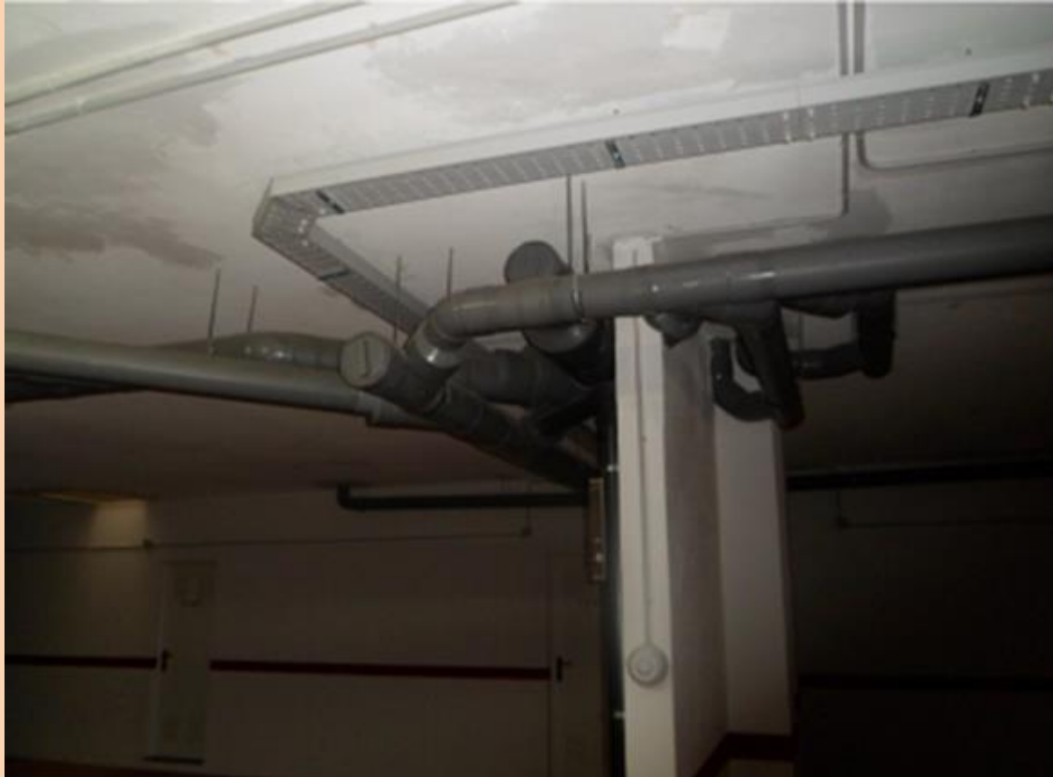
DETALLE REGISTRO COLECTOR
