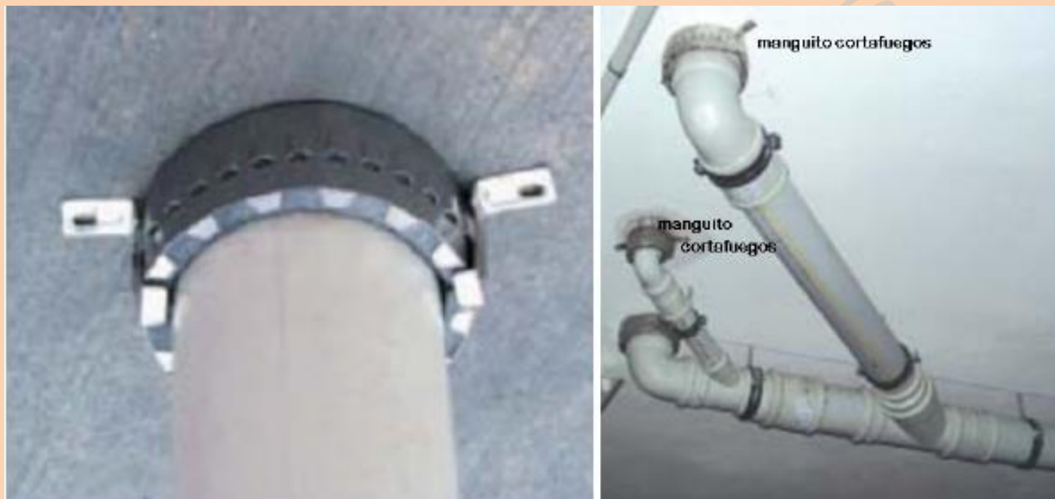
DETALLE MANGUITOS CORTAFUEGO
